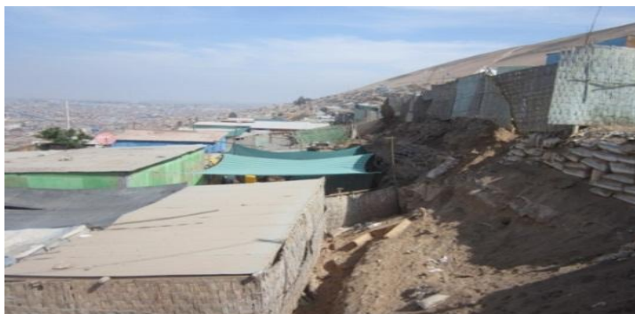
Imagen 85: Asentamiento Humano que se encuentra ubicada en el cerro Intiorko - Alto de la alianza, y asentada sobre material suelto y pendiente alta
